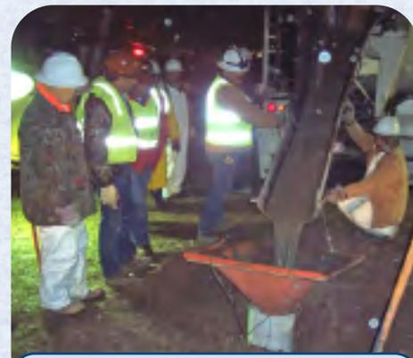
WORKING ON THE SURFACE AT NIGHT, THE CREWS COMPLETED THE GRAVITY GROUTING WITHOUT AFFECTING AIR TRAFFIC.
